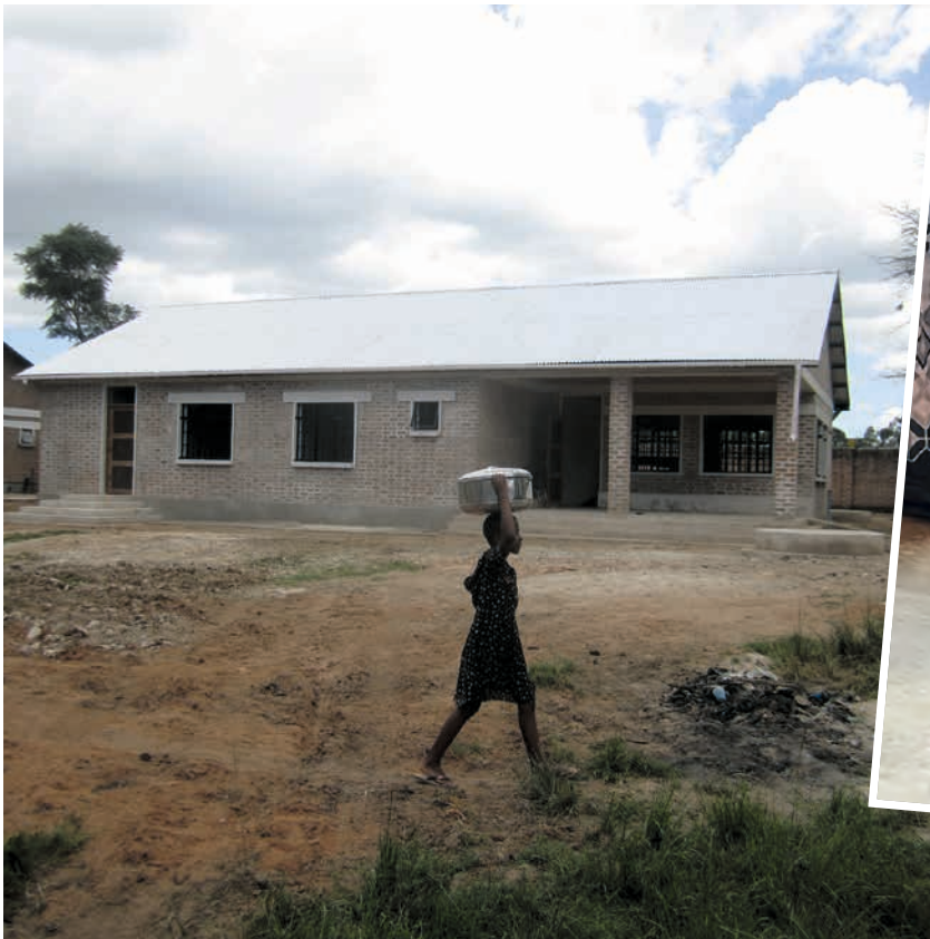
Das neue Gebäude hat eine Grundfläche von 184 m 2 und bietet mehrere Schlafräume für etwa 22 Kinder, ein Krankenzimmer, einen Aufenthaltsraum sowie Toiletten mit Waschmöglichkeiten.
