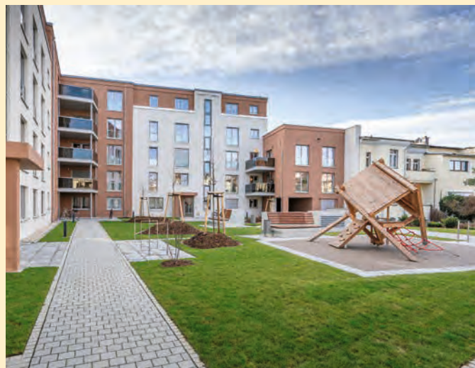
... zeigt die neuen Wohngebäude Bertheltstraße 7 / Hänelstraße 15 – 15a
