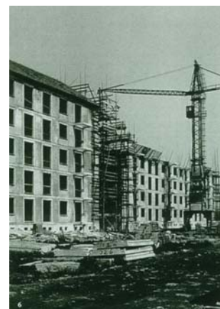
Rohbauzustand von Wohnbauten der Großblockbauweise in Dresden-Johannstadt, Striesener Straße. Bauzustand: Mai 1958
