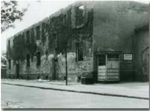
Wohnanlage Gruna - Brandruine des Wohngebäudes Am Ende 16/18.
