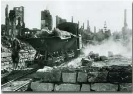
Nachdem im völlig zerstörten innerstädtischen Bereich die wichtigsten Straßenzüge notdürftig von Trümmern beräumt waren, wurde im Jahre 1946 im bescheidenen Umfang mit der Beräumung der ersten riesigen Trümmerfelder in der Johannstadt begonnen. Das Foto zeigt eindrucksvoll die Entrümmerungspraxis. Die schwere körperliche Arbeit wurde zu dieser Zeit zum größten Teil von Frauen geleistet.
