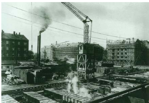
Oktober 1956: Fertigungsstätte für die Großblockbauweise des Pilotvorhabens Striesener Straße (Das Areal zwischen Laubstraße/Borsbergstraße und Müller-Berset-Straße). Das provisorische Heizhaus diente der Bedampfung der gefertigten Großblöcke. Bauzustand: Oktober 1956
