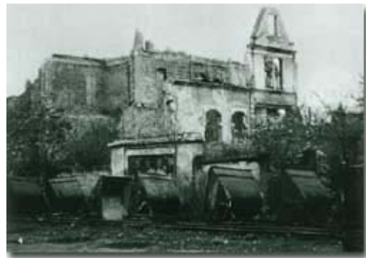
Die Comeniusstraße in Höhe der genossenschaftlichen Wohnbauten (Hausnummer 24) am 26.10.1956. Die Gleisanlagen der Trümmerbahn Johannstadt zum Trümmerberg Dobritz sind zu erkennen. In unmittelbarer Nachbarschaft des daneben liegenden Lokschuppens wurden - wie auf dem Foto erkennbar - die für die Reparatur bestimmten Loren abgestellt.
