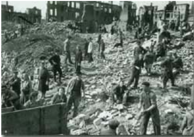
Freiwilliger Arbeitseinsatz in der Johannstadt im Jahre 1946. Hier galt der Einsatz der Bergung von Mauerziegeln. Weil auch dabei jede Art von technischen Hilfsmitteln fehlte, bildeten die Menschen zwei "Ketten", um durch ein Weiterreichen die Ziegel vom Trümmerberg zum Pferdefuhrwerk zu transportieren.
