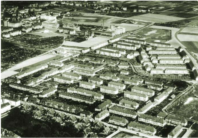
Luftbildaufnahme der vom "Bauverein Gartenheim" von 1919 und 1926 und dem "Dresdener Spar- und Bauverein" von 1924 und 1928 errichteten Wohnanlage in der Gemarkung Guna (Bildmitte).
