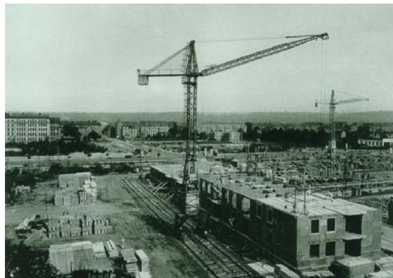
Baustelle an der Straßenkreuzung Striesener Straße/Müller-Berset-Straße. Bauzustand: Oktober 1956. Die Wohnbauten entlang der Müller-Berset-Straße befinden sich im Aufbau. Im Hintergrund rechts ist die Fertigungsstätte für die Großblöcke deutlich erkennbar.
