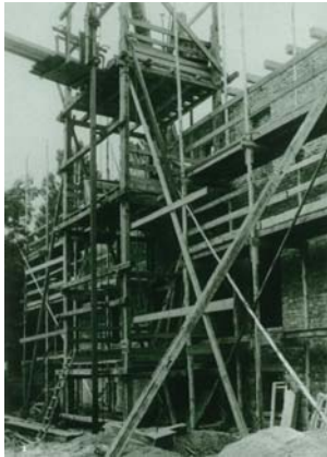
Eine um 1952 noch übliche Stangenrüstung mit Lastenaufzug im traditionellen Wohnungsbau.
