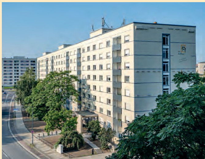
... zeigt das Wohngebäude Steinstraße 1–5 nach der Fassadensanierung.
